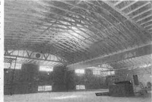
LID工法の施工例。在来工法の躯体に乘せるだけで合理化できる
